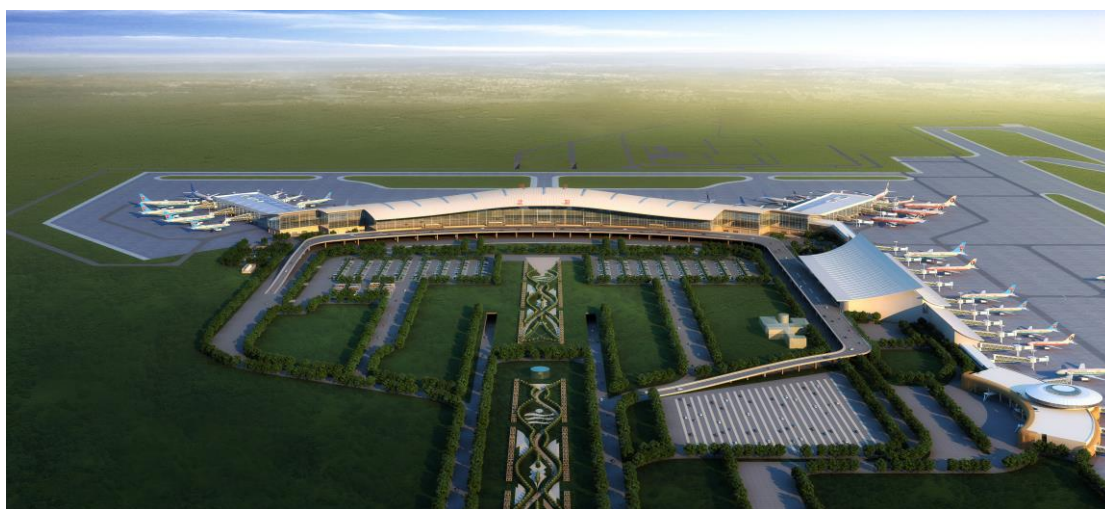
沈阳桃仙国际机场 T3 航站楼工程
