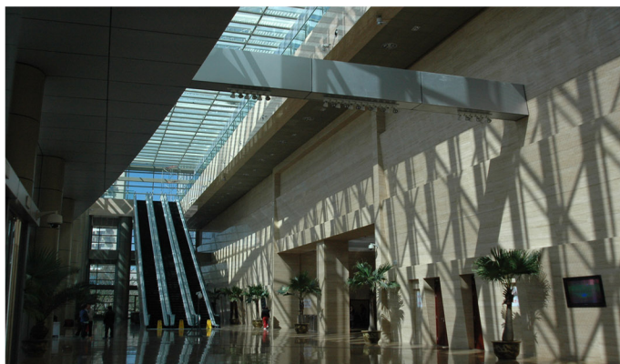
体育博览中心内跨高15米的中间无支撑扶梯
