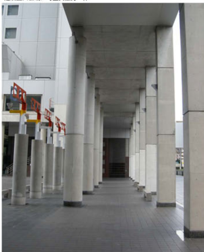
一层架空连廊，清水混凝土表面
