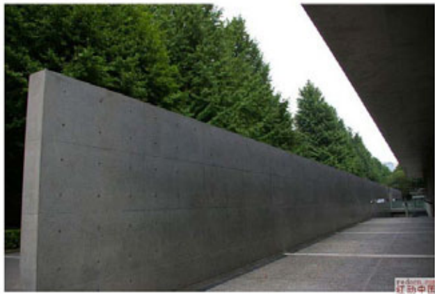
清水混凝土墙面
