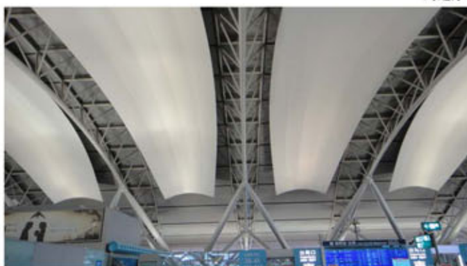
屋顶桁架结构
