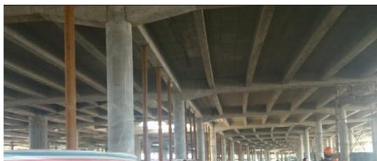
混凝土结构：主体结构采用现浇钢筋混凝土框架结构。一般楼板采用现浇普通钢筋混凝土梁板体系，主厅的环向梁及大跨度悬挑梁采用有粘结预应力混凝土结构，以控制结构变形和温度应力。地下室采用现浇整体防水混凝土梁板结构。
