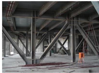
施工中的加强层钢桁架
